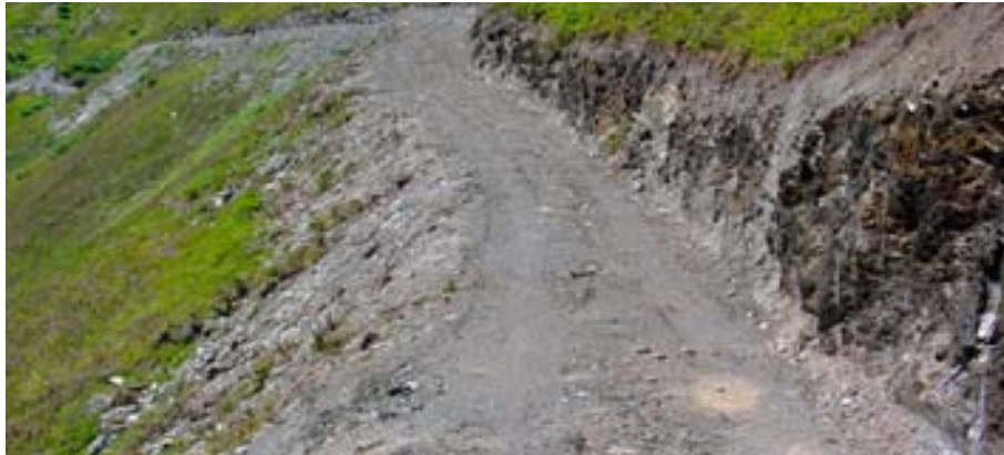
„Viehtriebweg“ zur Königsstuhlmalm – Breite und Ausformung sowie zum Teil extrem hohe Anschnitte geprägt durch das eingesetzte schwere Gerät. Breite bis 2,50 m Foto: LUA
