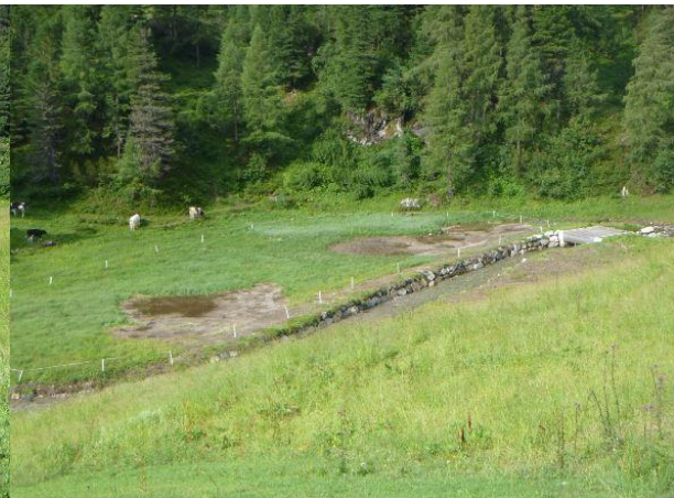
Hier sind die Ablagerungen bereits entfernt und das Gelände ist wieder annähernd in den ursprünglichen Zustand gebracht worden.
