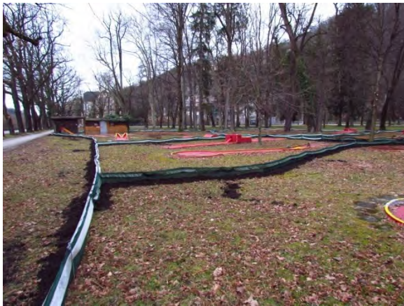
Errichtung von Fangfeldern im Bereich der Minigolfanlage, Foto: © Werner Krupitz
