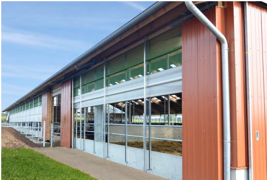
Beispiel eines modernen Rinderlaufstalls der Firma wolfsystem.de
