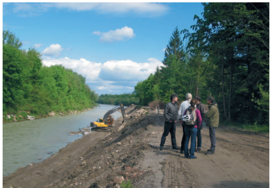
Ufersanierung an der Saalach
