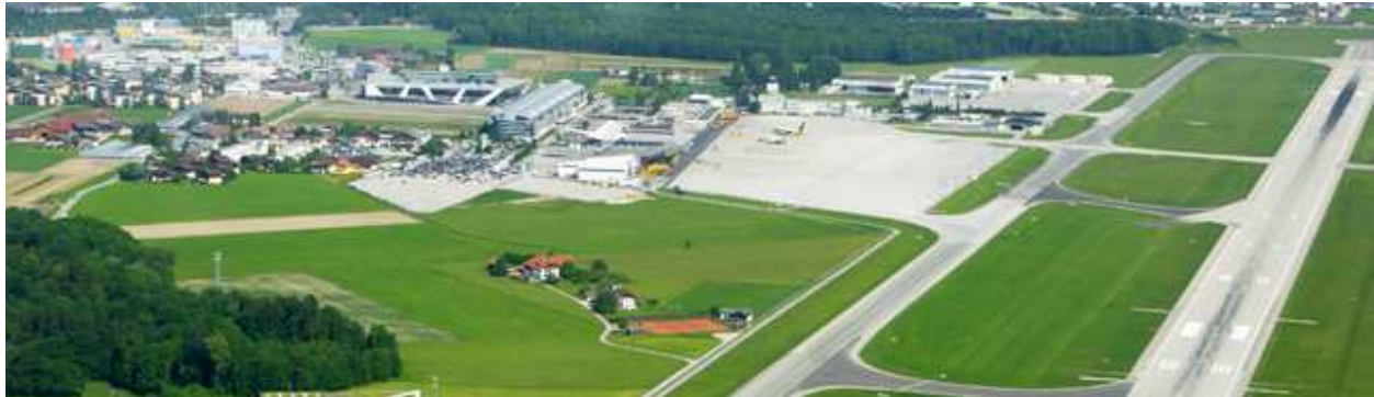
Schrägluftaufnahme aus Südanflug mit dem gegenständlichen Parkplatz P3A etwa mittig der linken Bildhälfte. Quelle: Internetportal des Salzburg Airport
